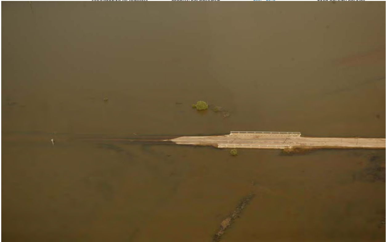
Figura 1.3. Șosea distrusă de inundații
